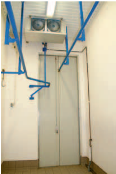
Bild 8a. Med två banor med olika höjd i samma kylrum (hög- och lågbana) har man möjlighet att växla mellan storboskap och småboskap. Observera att kylaggregatet kräver utrymme mellan tak och slaktbana. Bild 8b. Kylrum med slaktkropp.
