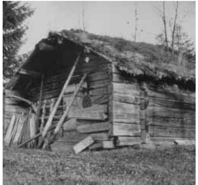
Fig. 2. Rökbastu av bilat timmer från Saxen i Åre socken, 4,65 m lång, 4,45 m bred, jordgolv, glugg på baksidan. Åstak med två par sidoåsar. Taket täckt med tvärgående stockar, brädor näver och torv. Ugn av hällar mitt på golvet. Lavar med fotbrädor efter långsidorna. (JLM 1959)
