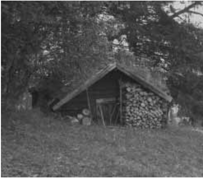
Fig. 4. Rökbastu av bilat timmer från Såå i Åre socken, 4 m lång, 4 m bred, jordgolv och mittstående ugn av flis och tegel. (JLM 1962)
