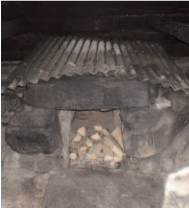
Fig. 11. Ugnen in rökbastun i Lierne. "Ildsted/gråsteinsovn i basstua på Oppgårdan i Kvelia. På sidene ser vi bjelker hvor det før lå store steinheller som det ble tørket korn på."
