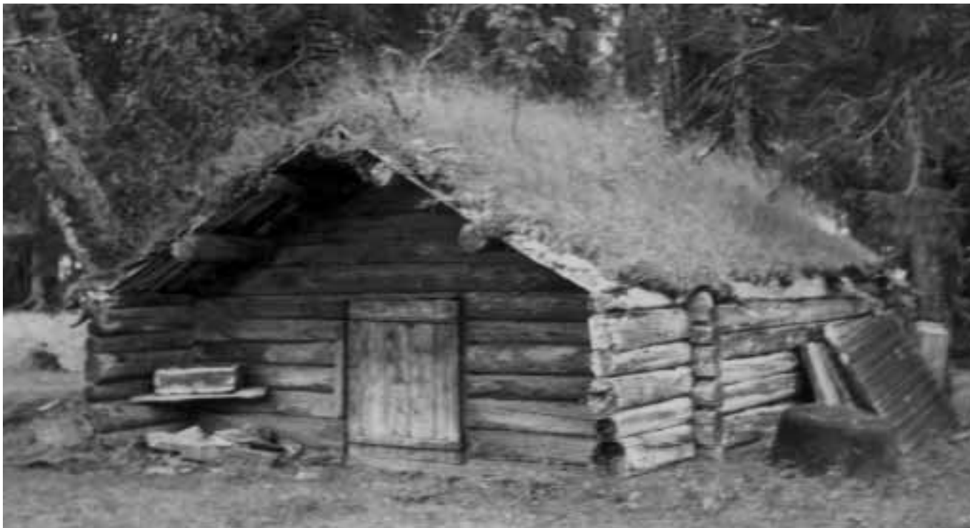
Fig. 3. Rökbastu av rödmålat rundtimmer från Klocka i Åre socken, 4,75 m lång, 4,40 m bred, jordgolv, tegelugn täckt med stenplattor. Åstak med två par sidoåsar täckt med slånor, näver och torv, innertak saknas. Glugg i bakre gaveln. (JLM 1959)
