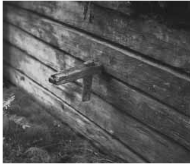
Fig. 5. Lavar längs bägge långsidorna skjuter ut i kortsidornas väggar och stöds av ett tvärträ, utskjutande i långsidornas mitt fasthållen av en kil. (JLM 1962)
